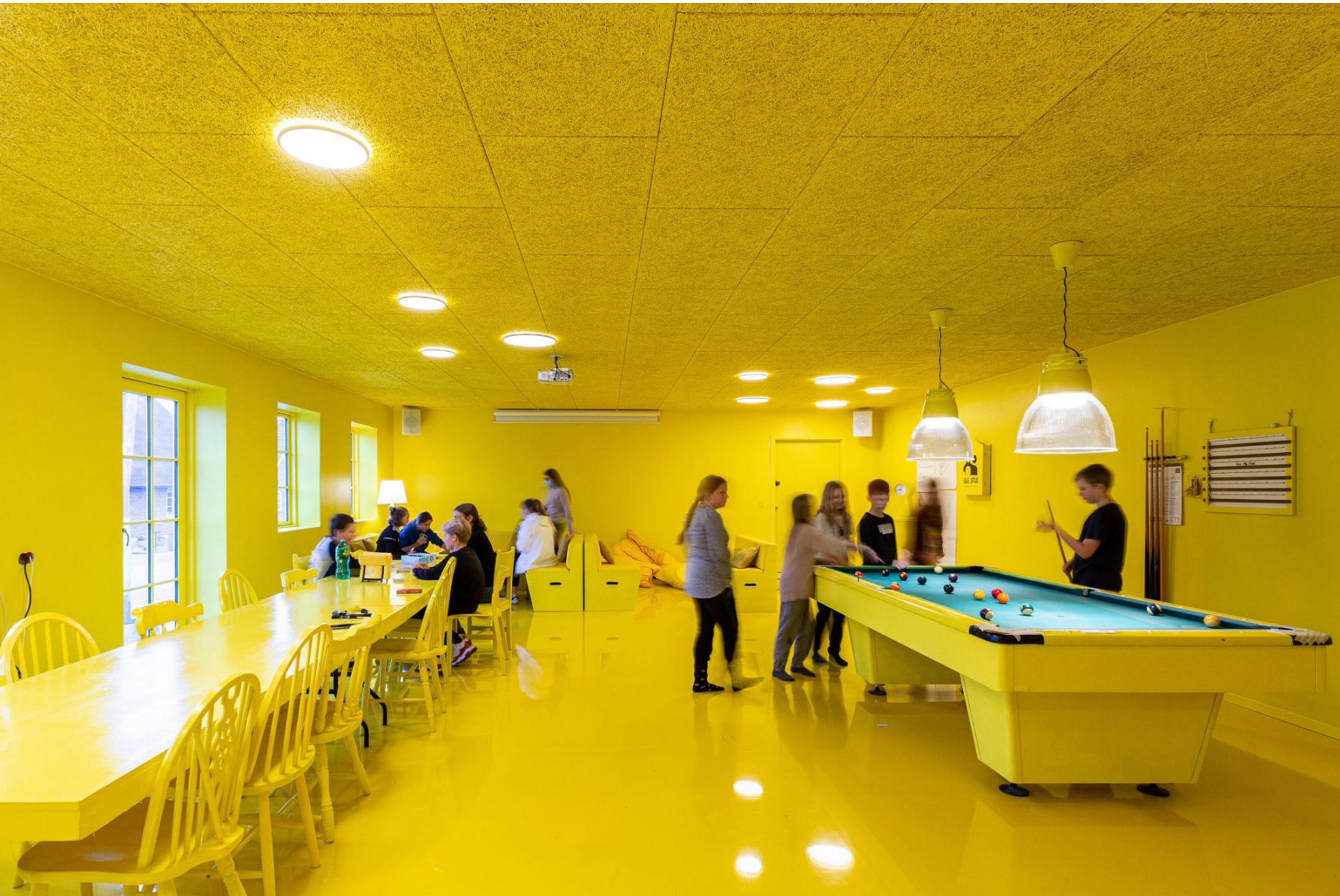
Acoustic Panels ↑ Revestimiento de techo
